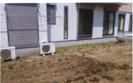
窓の外にステップがなく、庭に出られない
